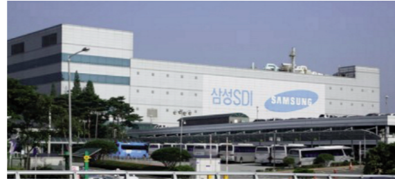
Project Name : UT1bd Pipe Construction Client : Samsung SDI (Cheon-An) PJT Period : 2012
