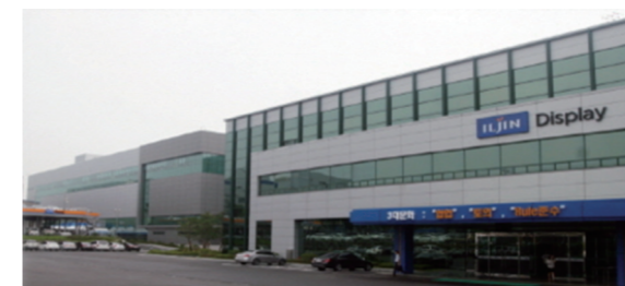
Project Name : Display CLEAN ROOM Construction Client : Il-Jin Display (Pyeong-Taek) PJT Period : 2012 ~ 2015
