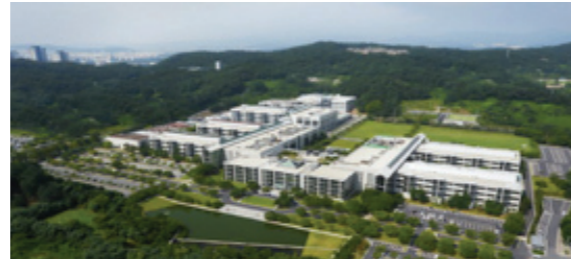
Project Name : SKIET P#2,3&4 Dry Room EPC Construction Client : SKIET (Katowice, Poland) PJT Period : 2021~Processing
